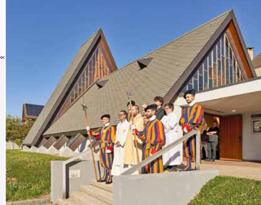
L'inclinaison du toit de la chapelle de Begnins est idéale pour installer des panneaux solaires.
